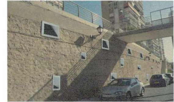
07 Túnel Finca ADOC
